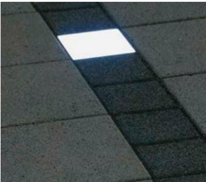
Eingangsbereich mit FOCUS® LED-PFLASTERLEUCHTEN in ARCADO®-Pflasterbelag
